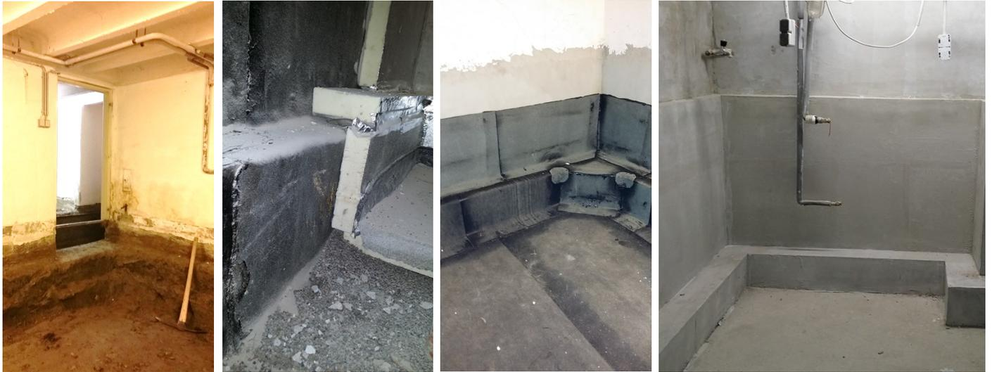
*Abb.1: Abgraben zwischen den Streifenfundamenten und vergrößern der Kellerraumhöhe, Dämmen der Bodenplatte und der Kellerwände*
