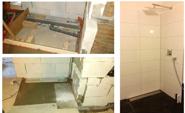
Abb. 8: Phasen der Sanierung des Bades mit dem Einbau einer DWRG
