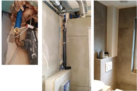
Abb.11: Fotos der DWRG im Gebäude „Am Gießen“, links der Anschluss mit einem Duschröhr, in der Mitte das vertikale DWRG System, rechts die Situation nach Abschluss der Arbeiten
